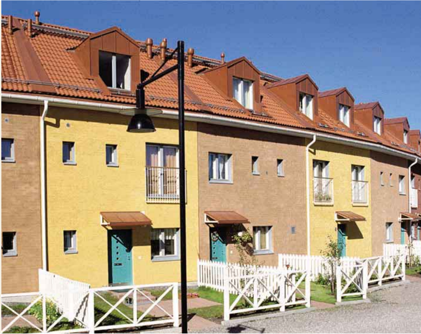
Tiili rappauksen alla: Keltaiseksi oksidoitu kuultorappaustiili Rappaus: Hierretty 1-kerrosrappaus
